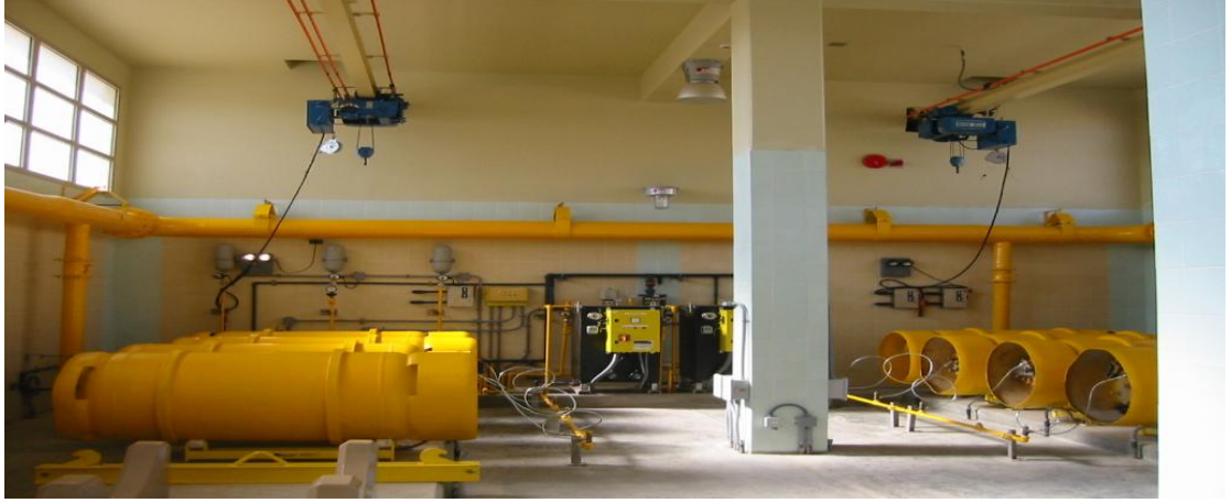
شكل رقم ( 7 ) عنبر إسطوانات الكلور
