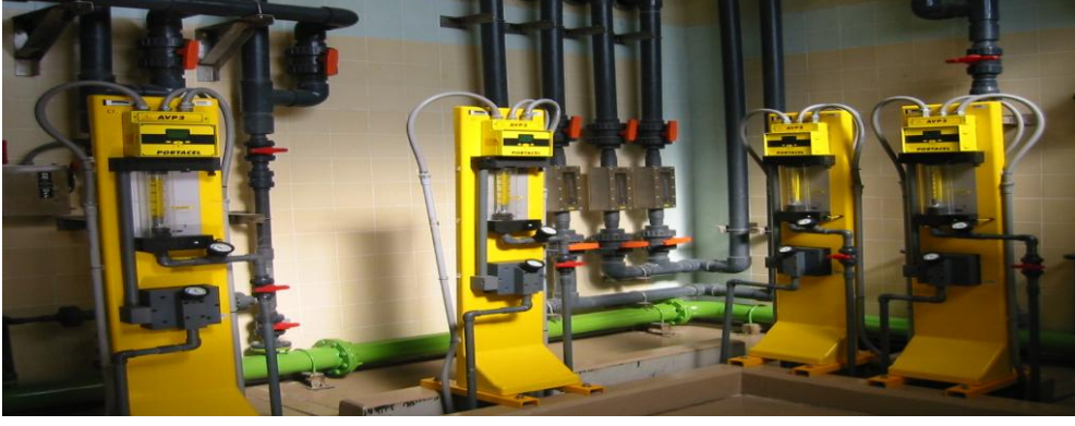
شكل رقم ( 17 ) كبائن حقن الكلور والحاقدن
