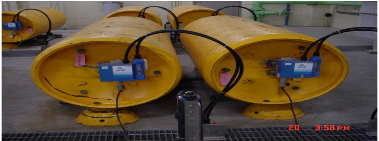
شكل رقم ( 28 ) أسطوانة كلور سعة واحد طن
