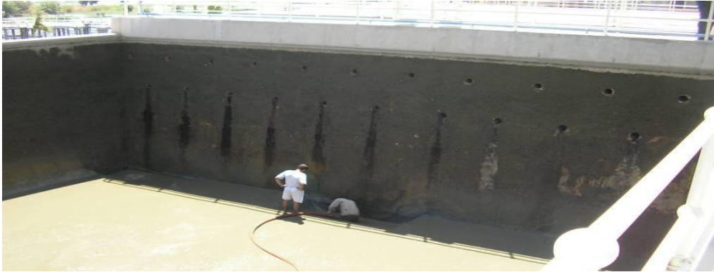
شكل رقم ( 18 ) منطقة دخول المياه
