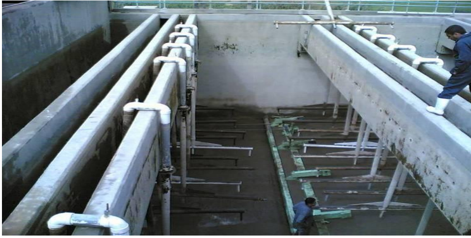
شكل رقم (24) كاسحة الروبسه الافقيه
