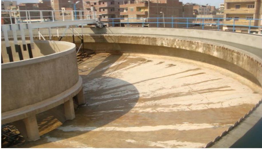
شكل رقم ( 16 ) منطقة تجميع الروبة
