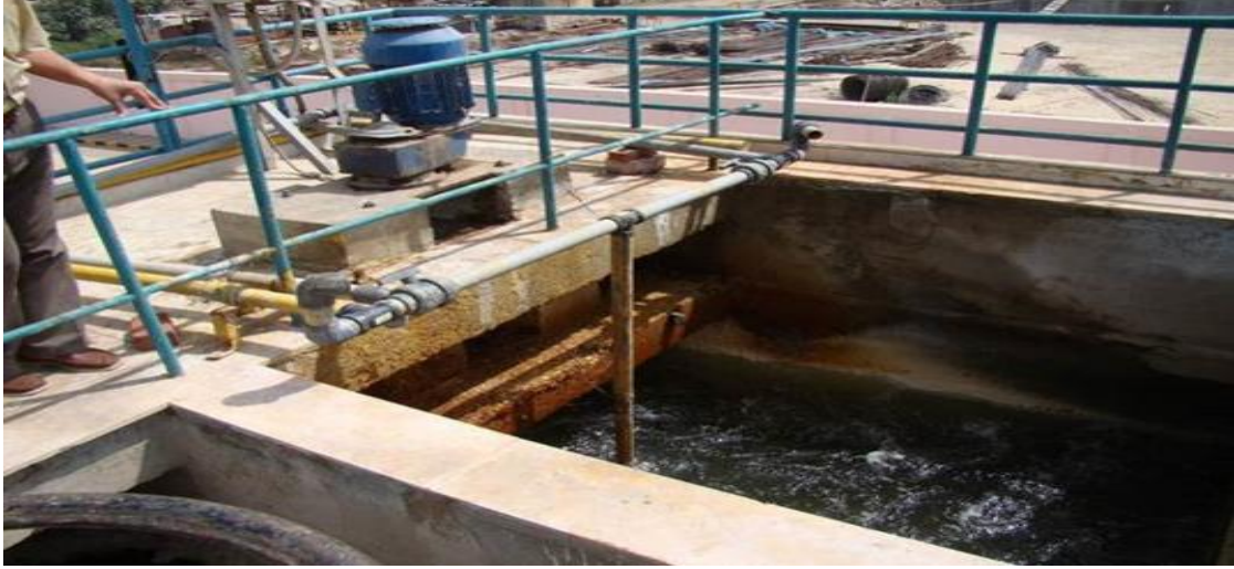
شكل رقم ( 9 ) الترويب الميكانيكي
