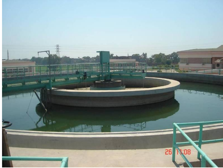
شكل رقم ( 14 ) منطقة الدخول وهي حيث يتم توزيع المياه اسفل المروك
