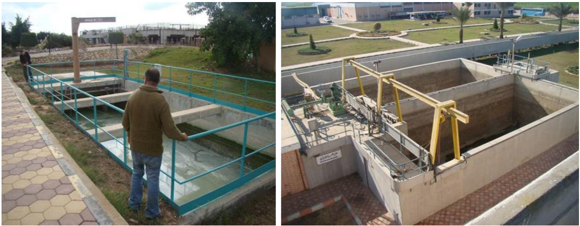
شكل رقم ( 25 ) بيارات معالجة الروبسه
