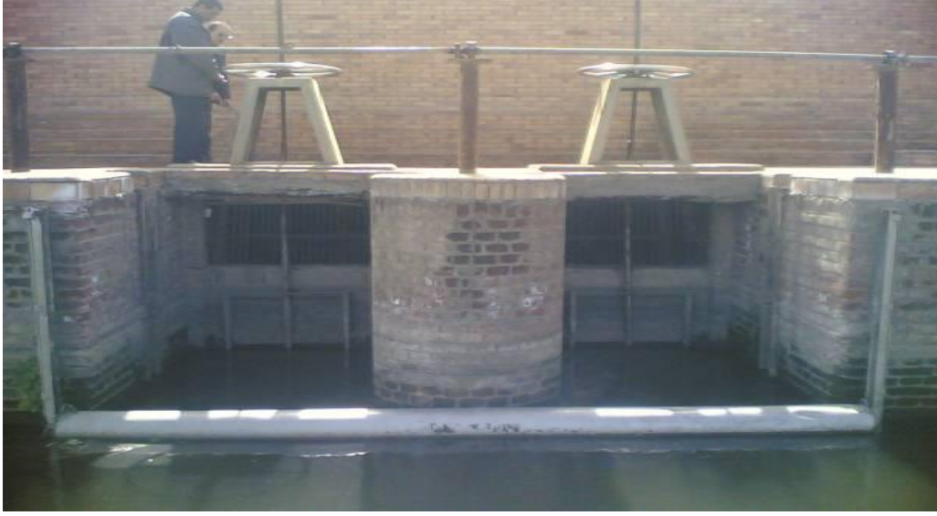
شكل رقم ( 2 ) توضيحي لمأخذ شاطئ
