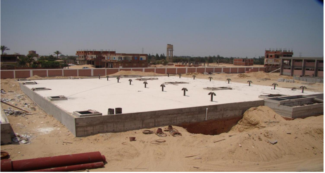
شكل رقم ( 12 ) توضيحي لخزان أرضى بمحطة
