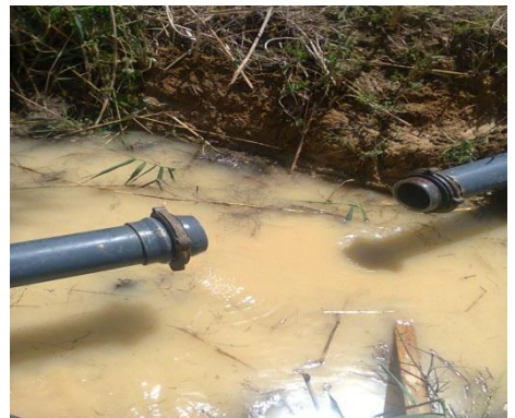
شكل ( 7 ) صور لإصلاح كسر حلقى فى ماسورة بلاستيك 12 بوصة بتركيب عدد 2 جيبولت
