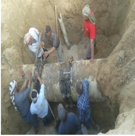
شكل ( 6 ) إصلاح كسر حلقى فى ماسورة GRP
