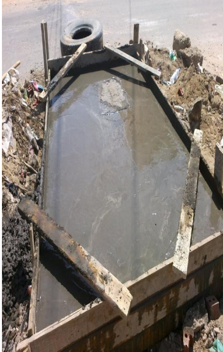
شكل (1) بعض الصور توضح بعض الإجراءات لرفع منسوب غرف المحابس السطحية
