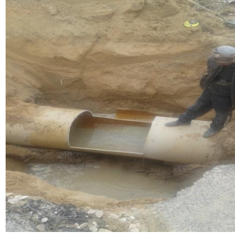
شكل ( 6 ) إصلاح كسر حلقى فى ماسورة GRP
