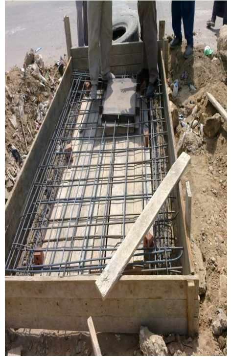
شكل (1) بعض الصور توضح بعض الإجراءات لرفع منسوب غرف المحابس السطحية
