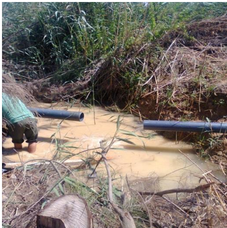
شكل ( 7 ) صور لإصلاح كسر حلقى فى ماسورة بلاستيك 12 بوصة بتركيب عدد 2 جيبولت
