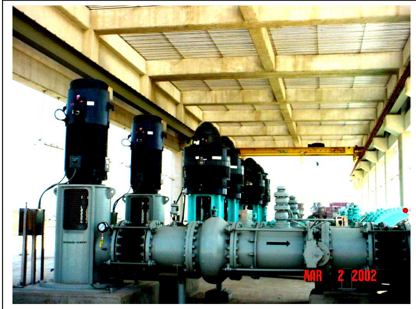
شكل رقم (15) طلمبات المياه المرشحة
