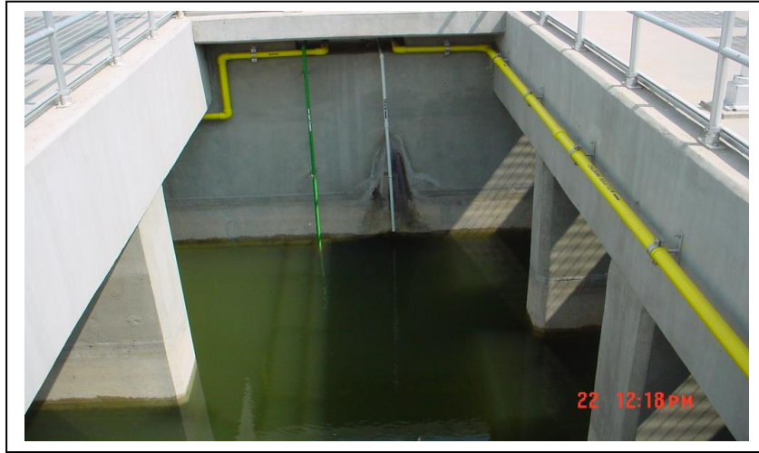
شكل رقم (4) بيارة المياه العكرة
