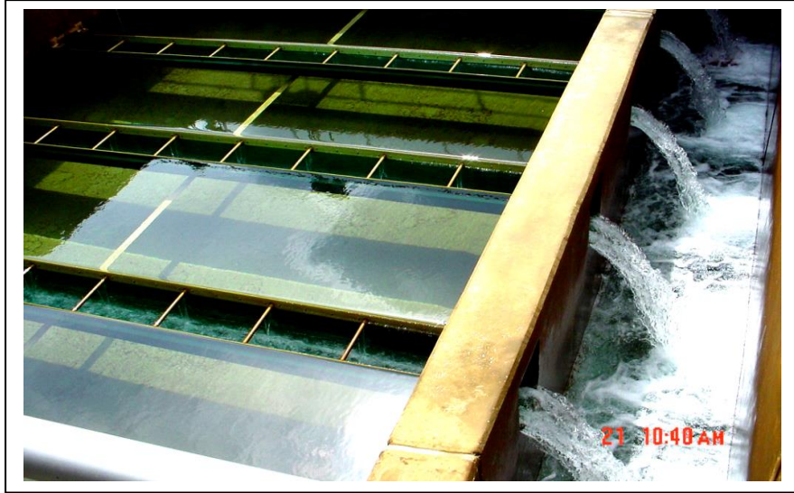
شكل رقم (13) المرشح الرملي السريع اثناء عملية الغسيل
