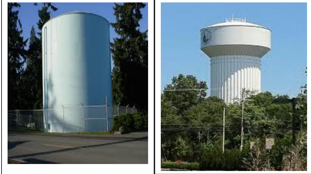
شكل رقم (20) خزان عالي وخزان سطحي
