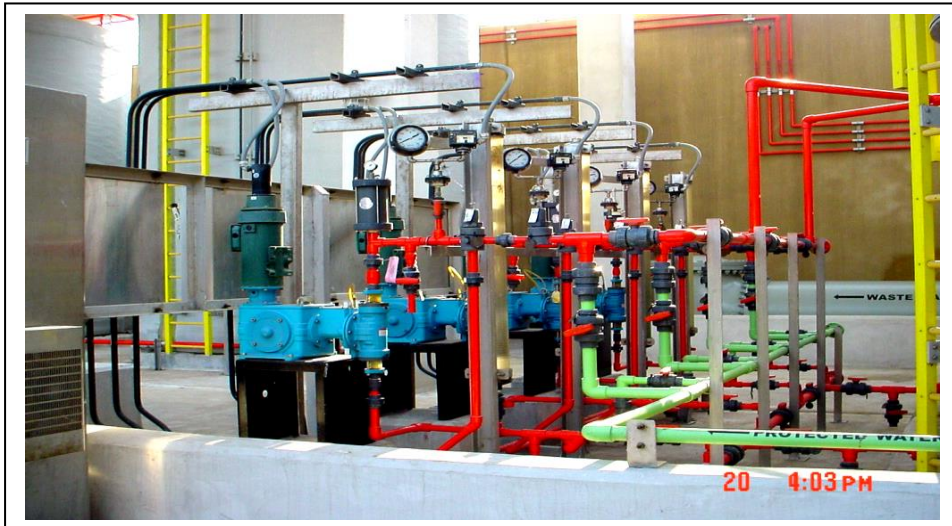
شكل رقم (11) مضخات حقن محلول الشب
