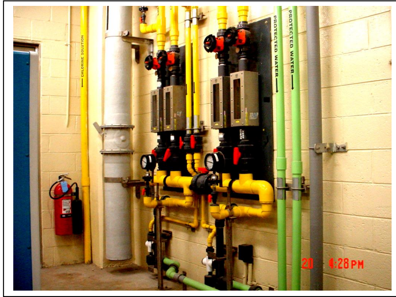
شكل رقم (14) أجهزة حقن الكلور
