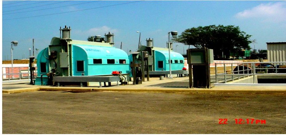
شكل رقم (3) المصافي الدقيقة
