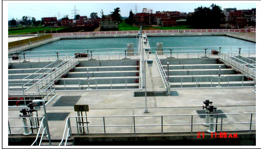
شكل رقم (12) حوض الترويب والترويق المشتركة
