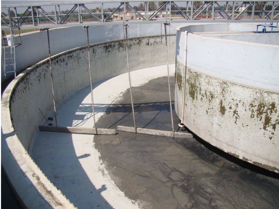
شكل رقم (3) كساحة تجميع الروبة
