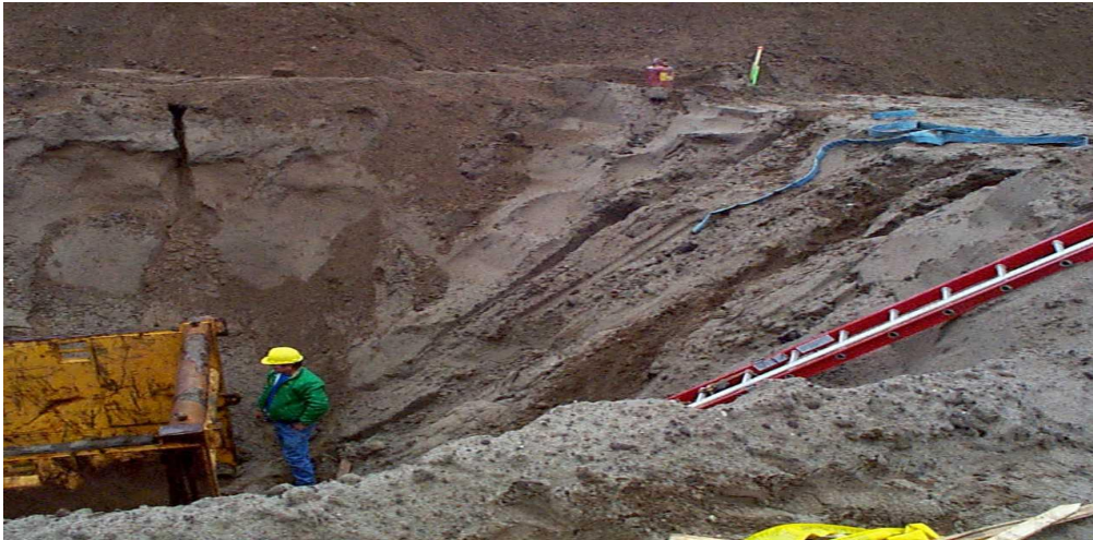
شكل 3- صورة لجانب من أعمال الحفر
