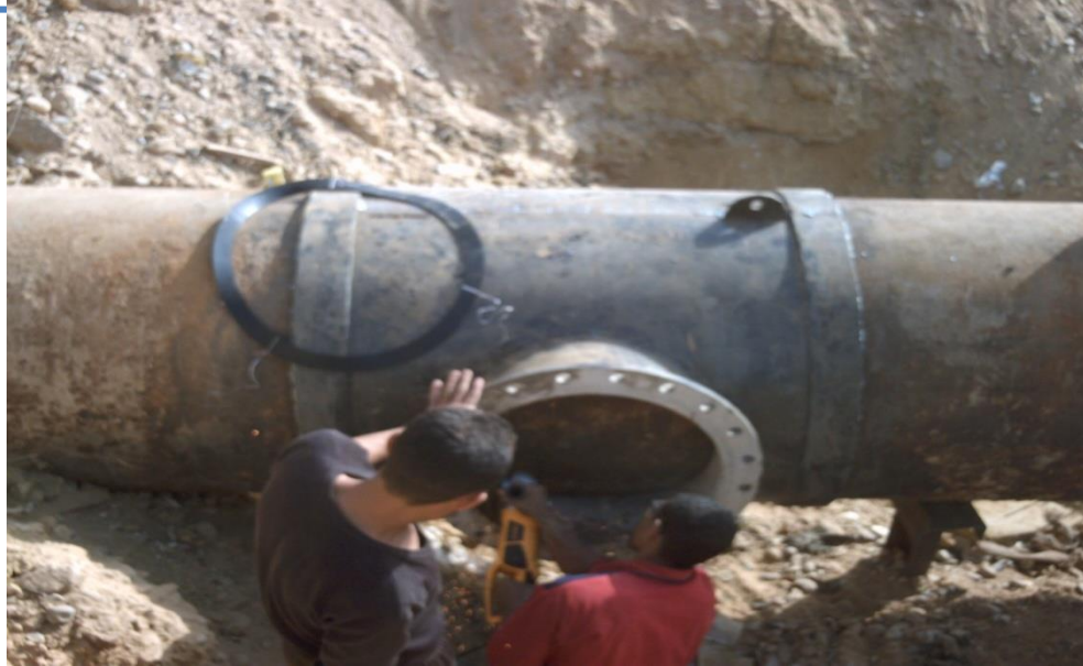
شكل 10- منشون صلب مصنع مع صب الرصاص او التركيب بالجوايط مع الجوان
