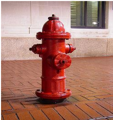
شكل رقم 15 - حنفية حريق عمودية
