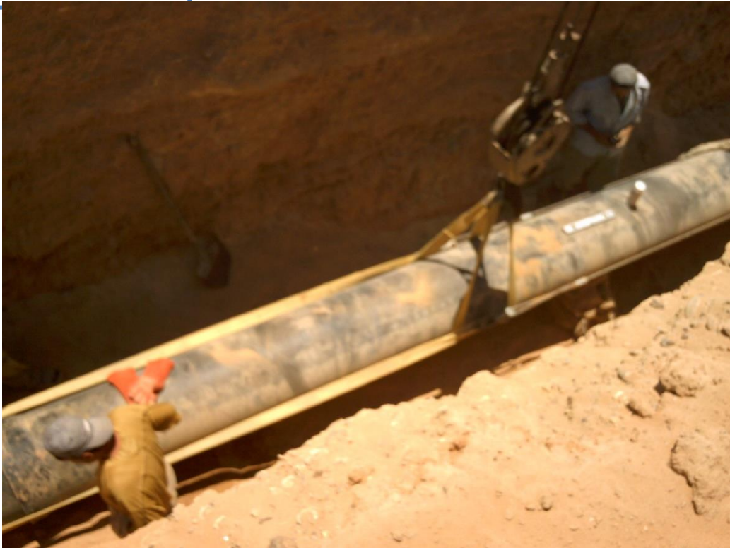
شكل رقم 2- صورة من الواقع لعملية إنزال المواسير
