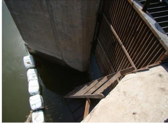
شكل رقم 2- شكل توضيحي للمصافي ذات القضبان
