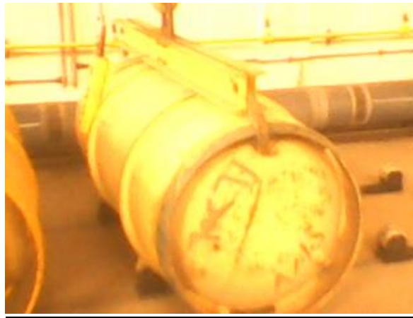
صورة توضح أسطوانة غاز الكلور سعة واحد طن
