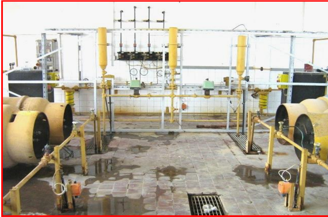
صورة رقم (1-6) عنبر اسطوانات الكلور
