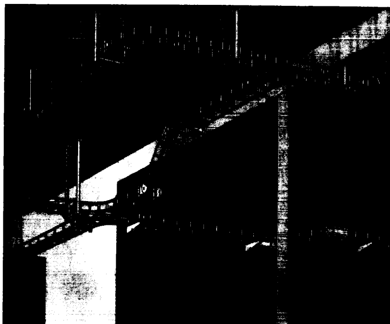
شكل (م ٢٢/٣/٤): حوامل الكابلات ذات الشكل السلمى
