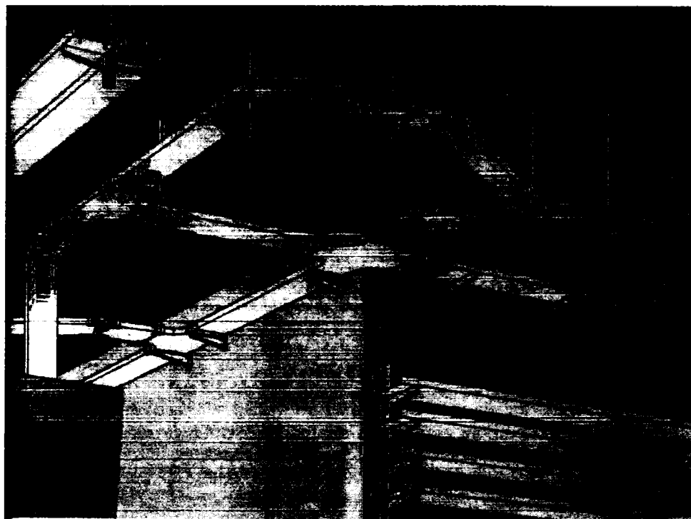
شكل (م ٢٣/٣/٤): حوامل الكابلات ذات الشكل الحوضى المثقّب والمصمت
