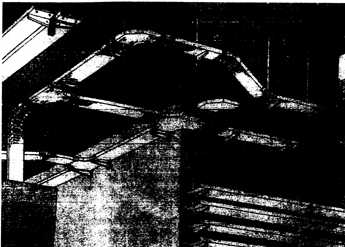
شكل رقم (٦-٢٠): حوامل الكابلات ذات الشكل الحوضي المثقوب والمصمت
