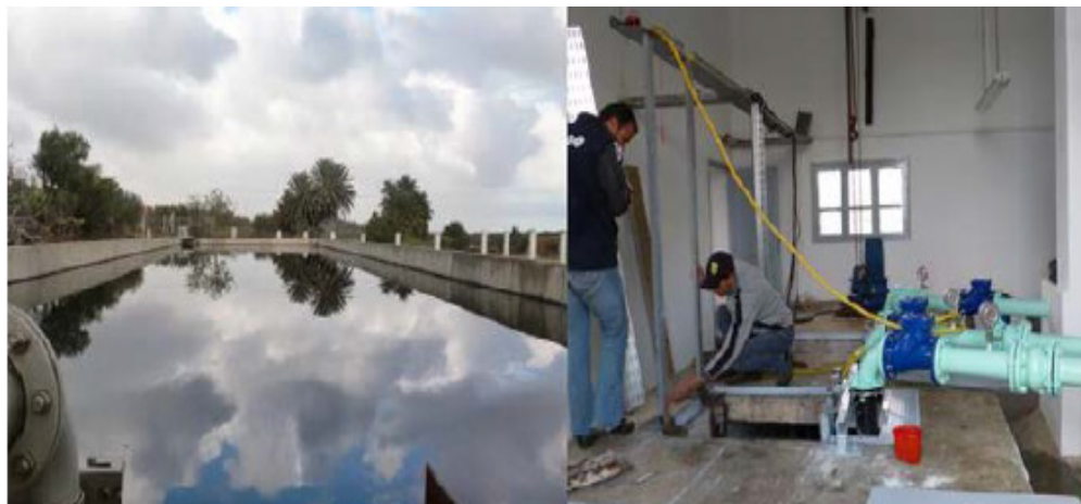
الشكل 6: حوض تخزين 1000 م 3 وصيانة محطة الضخ في الوردانين Ouardanine (بإذن من محجوب 2015) (with permission of O. Mahjoub 2015).
