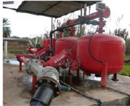
الشكل 8: مجموعة المرشحات في مخرج حوض التخزين (بإذن من محجوب 2015) (with permission of O. Mahjoub 2015).
