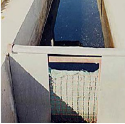
الشكل 7: شبكة مركبة في مخرج محطة معالجة مياه الصرف الصحي WWTP في الوردانين Ouardanine في عام 2003 (يسار) والمنخل الجديد، والشبكة التي تم تركيبها في عام 2004 (يمين) (بإذن من محجوب، 2003، 2015) (with permission of O. Mahjoub, 2003, 2015).
