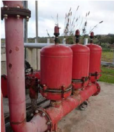
الشكل 8: مجموعة المرشحات في مخرج حوض التخزين (بإذن من محجوب 2015) (with permission of O. Mahjoub 2015).
