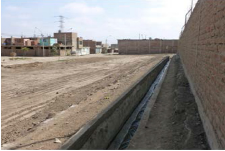
الشكل 2 : التجمع السكاني لا فلوريدا 2 La Florida II: قناة سان خوسيه San Jose للري ومنطقة المشروع على يسار القناة قبل البناء (الصورة: إيفا نيمكوف (Eva Nemcova).
